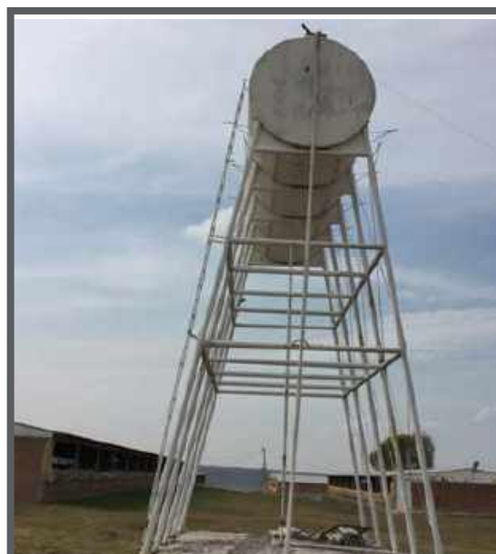
Depósito de agua
